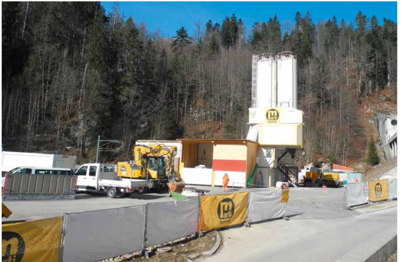
Une base de travaux importante avec centrale à béton a été implantée aux Convers, entre les deux tunnels de la ligne et de la route N 20. (Photo nm).
